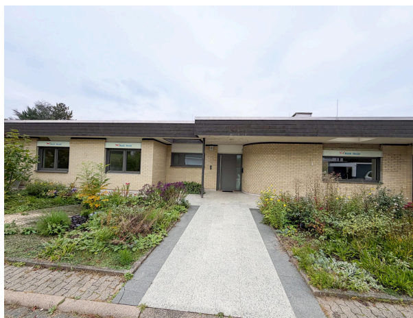
Widok bungalowa z boku w trakcie renowacji.
