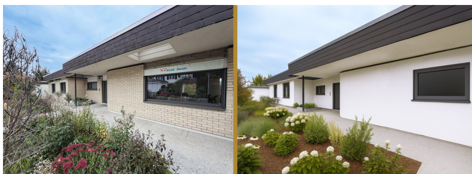
Prima: finestre obsolete con isolamento migliorabile
