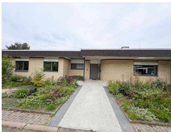
Vista laterale del bungalow durante la ristrutturazione.
