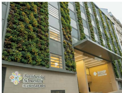
Begrünte neue Fassade in Wien
