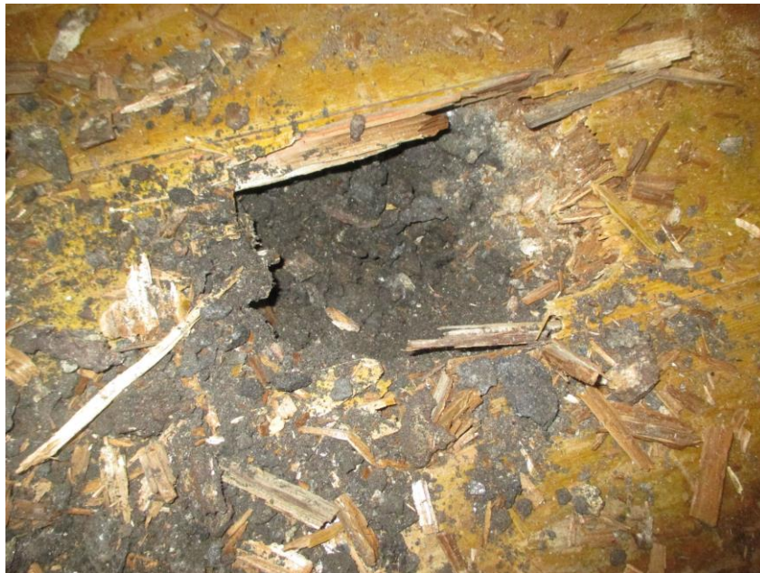
Foto 16: Bodenaufbau Zimmer 1, EG Wohnhaus
