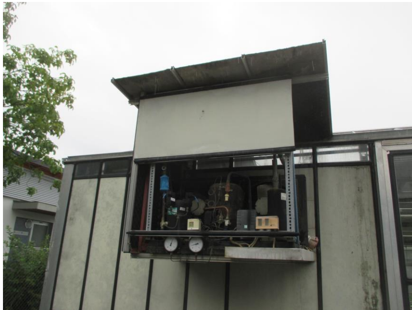
Foto 6: Kältaggregat für Kühlraum im Gewächshaus
