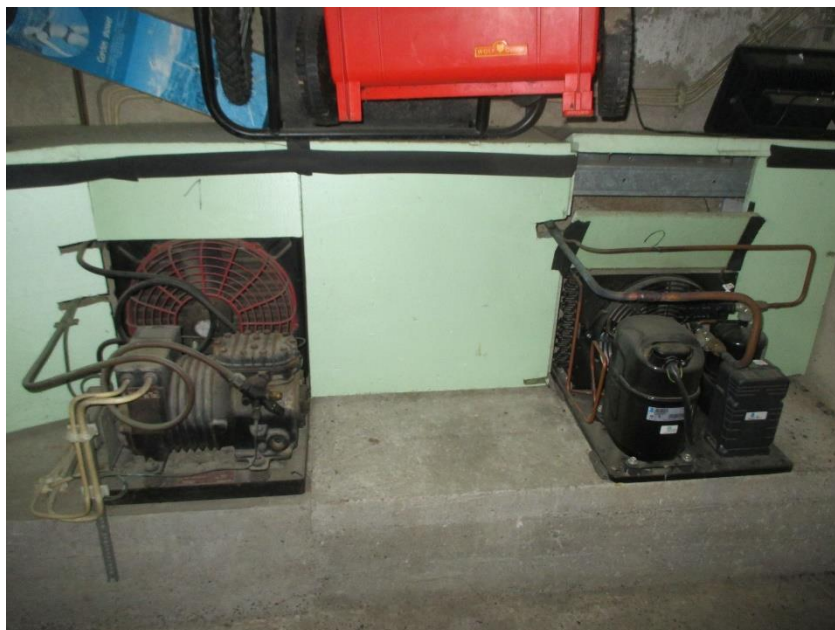
Foto 8: Kühlaggregate für ehem. Kühlraum im Lager
