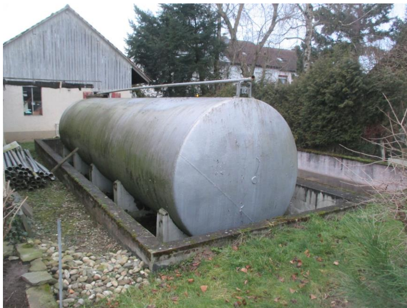
Foto 4: Heizöltank mit Betonwanne
