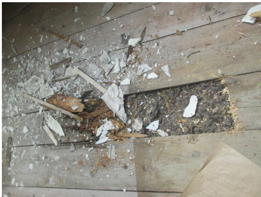
Foto 20: Bodenaufbau Zimmer 6, OG Wohnhaus
