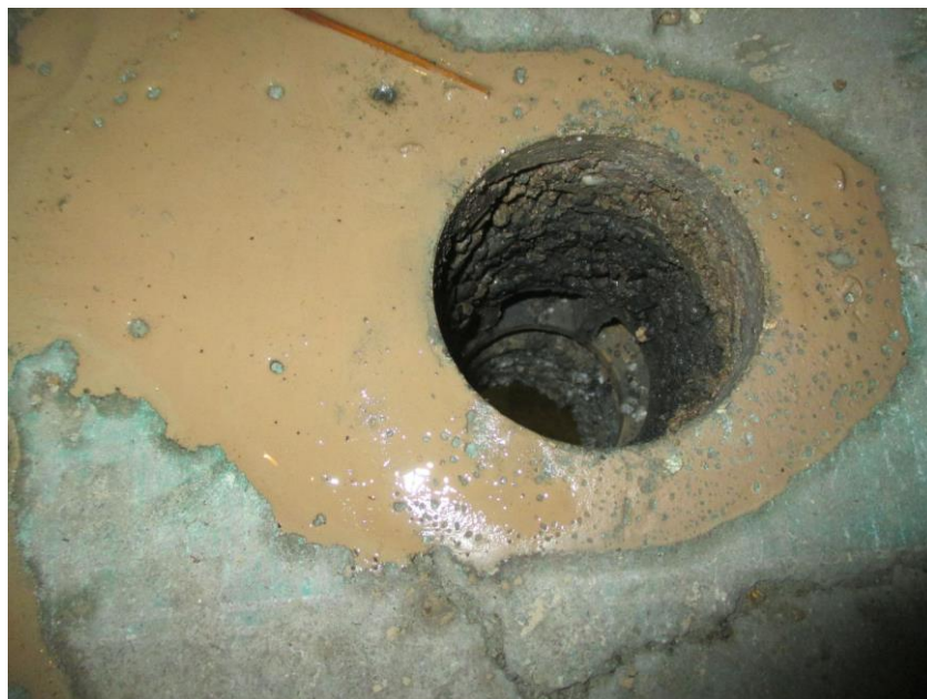
Foto 10: Deckendurchbruch Kühlraum, Lager
