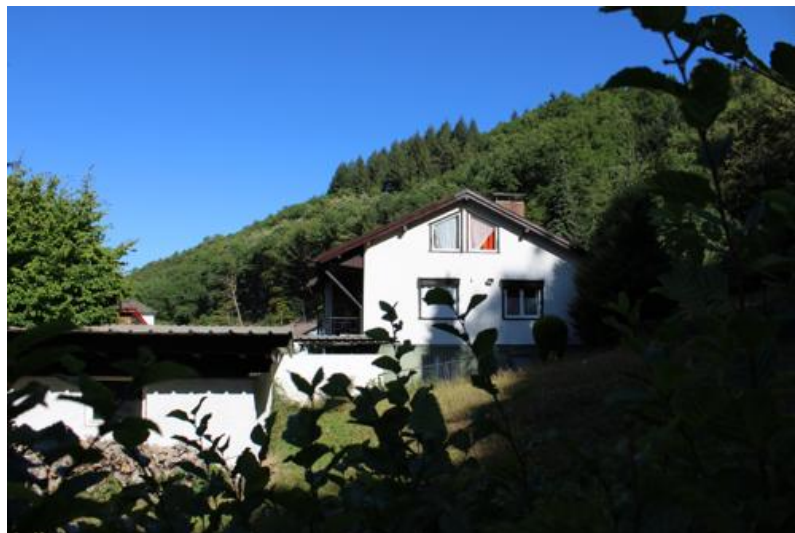
Abbildung 8.2: Süd-Ostansicht SR-02 (Am Lindengraben 2; 79410 Badenweiler)
