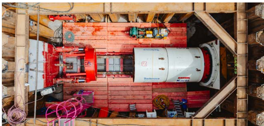
Die Tunnelbohrmaschine Karla in der Baugrube kurz vor dem Bohrstart
