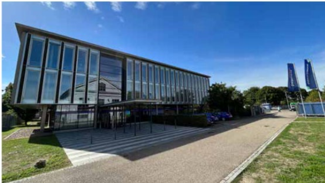
Abbildung 11: Standort Offenburg, Außenansicht
