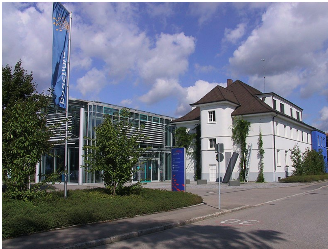
Abbildung 12: Standort Lörrach, Außenansicht
