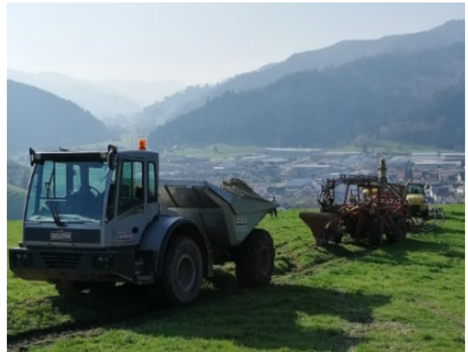
Pflügen der Kabeltrasse in offenem Gelände oberhalb von Hausach
