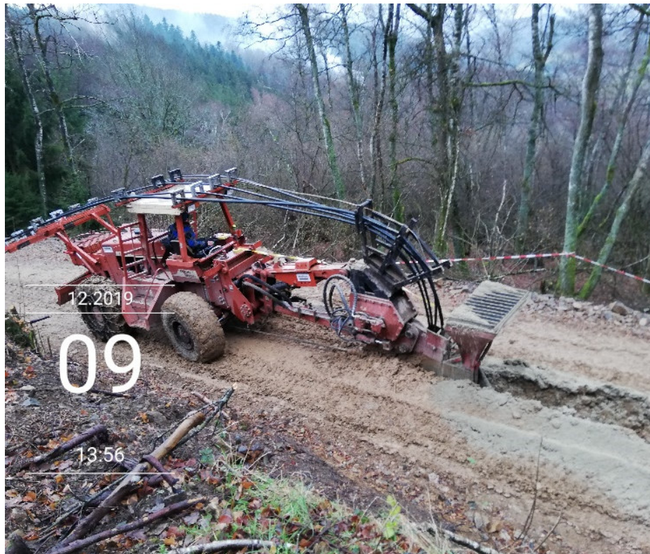
Pflügen der Kabeltrasse auf Forstwegen
