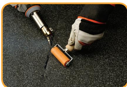
Saldatrice ad aria calda manuale
