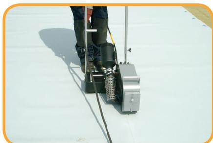
Saldatrice ad aria calda automatica
