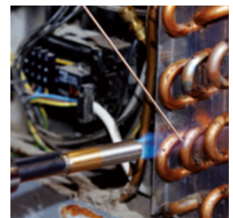
Hartlöten in der Kälte-Klima-Technik
