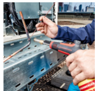
Hartlöten in der Kälte-Klima-Technik
