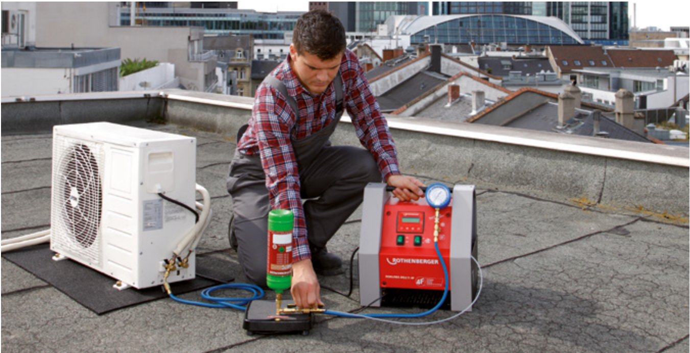
ROKLIMA MULTI 4F im Einsatz (Evakuieren und Befüllen)
