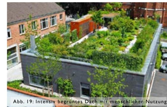
Abb. 19: Intensiv begrüntes Dach mit menschlicher Nutzung
