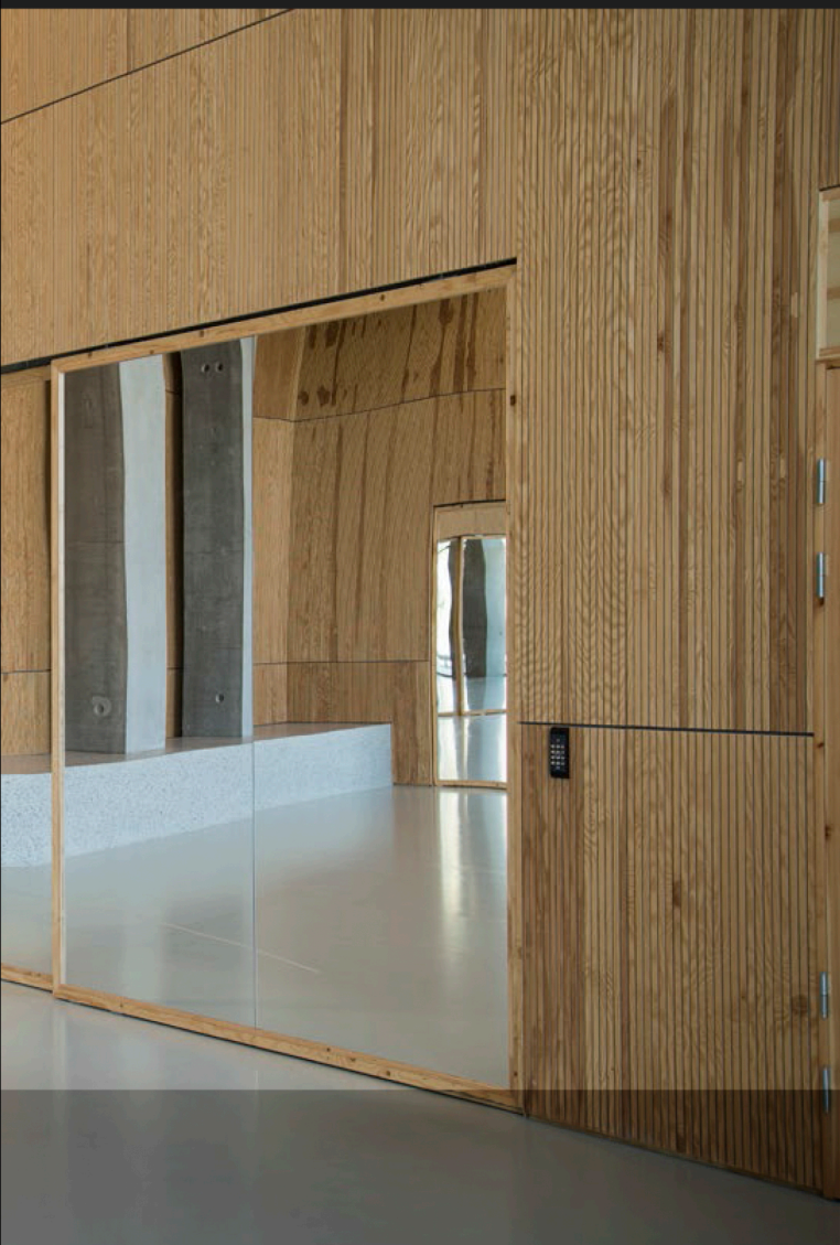
Projektspot fra Kalvebod Fælled Skole. Undervisningslokaler. Brandklassificeret EI30, lyd målt på stedet til R'w 44 dB - trædør i skrællet fyrre finér.
