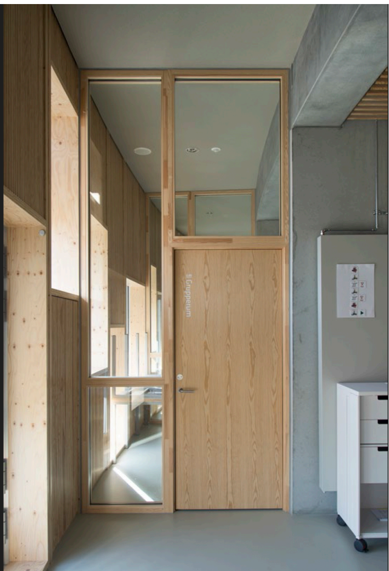
Projektspot fra Kalvebod Fælled Skole. Undervisningslokaler. Brandklassificeret EI30, lyd målt på stedet til R'w 44 dB - trædør i skrællet fyrre finér.
