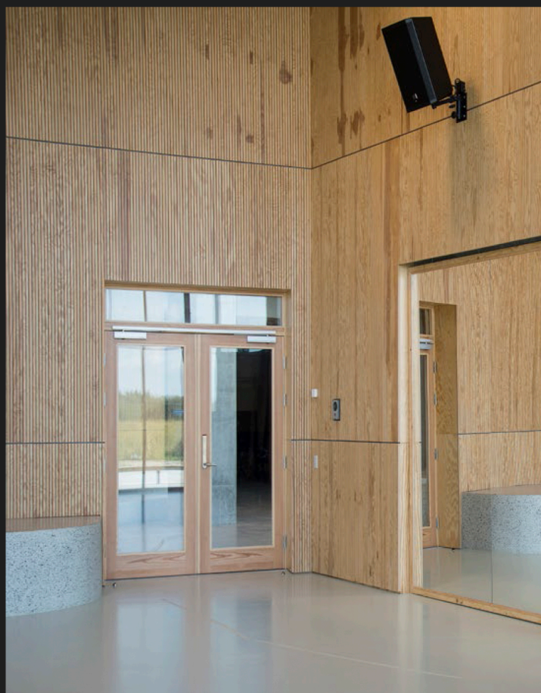
Projektpot fra Kalvebod Fælled Skole. Lille gymnastiksal Dobbelt glasrammedør EI60 med adgangskontrol.
