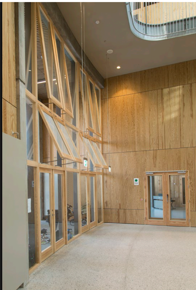
Projektpot fra Kalvebod Fælled Skole. Indgangsparti. 6,3 meter højt træ-, dør- og glasparti med røgventilation.
