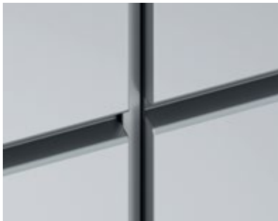
Q2A (horizontale Fuge 20 mm)
