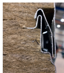
Obr. 40 – správná poloha roznášecí podložky
