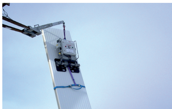
Малюнок 20. Підйом правильно закріпленої панелі за допомогою вакуумних присосок і ремінців.
