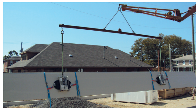
Малюнок 23. Сендвіч-панель, правильно закріплена для подальшого складання.
