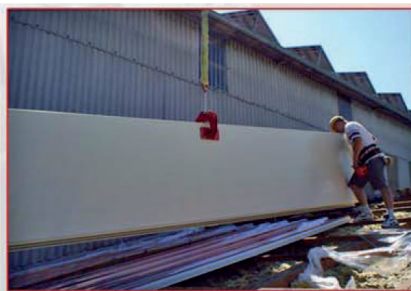
Малюнок 26. Етапи транспортування панелей даху за допомогою самоблокуючого монтажного інструменту.
