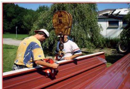
Малюнок 26. Етапи транспортування панелей даху за допомогою самоблокуючого монтажного інструменту.
