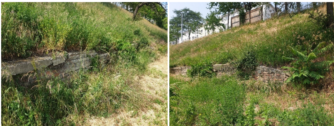
Abbildung 38 und Abbildung 39: Vertikale Gemäuer stellen eigentlich ein gutes Mauereidechsenhabitat dar und sind somit weitere, potentielle Mauereidechsenhabitate am Gelände.
