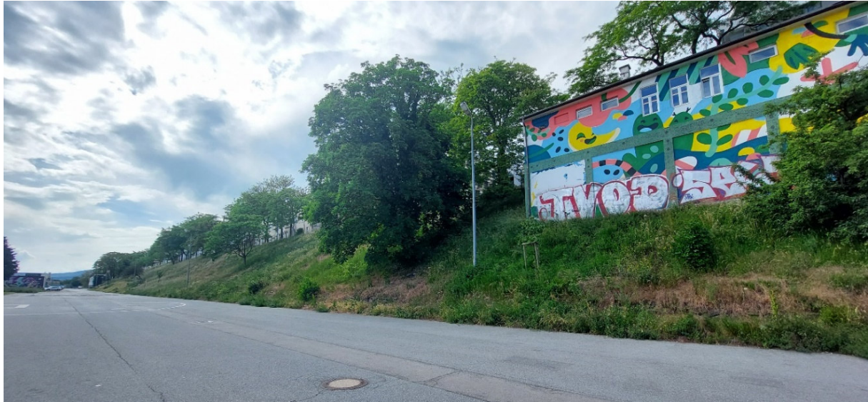
Abbildung 9: Die südexponierte Böschung der Entwicklungsfläche Felberstraße I (Teilbereich 5).
