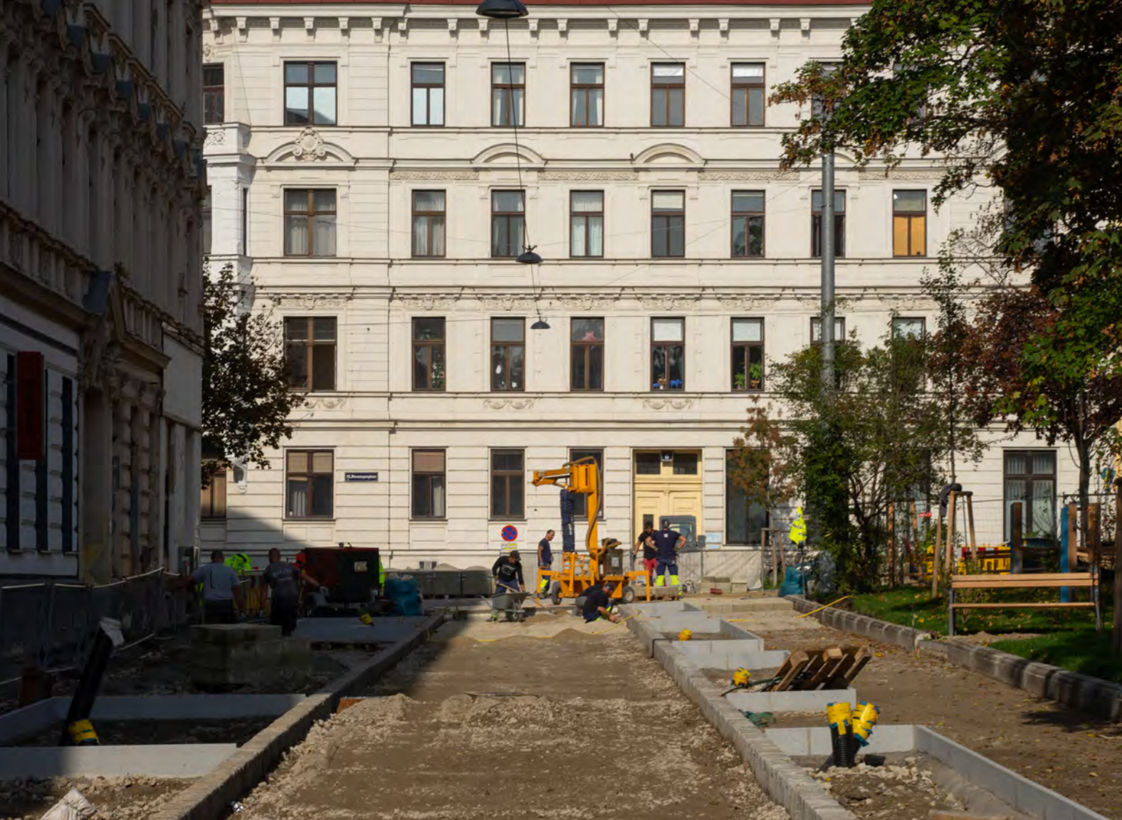
Bauarbeiten am Wienerplatz © Clara Maria Fickl
