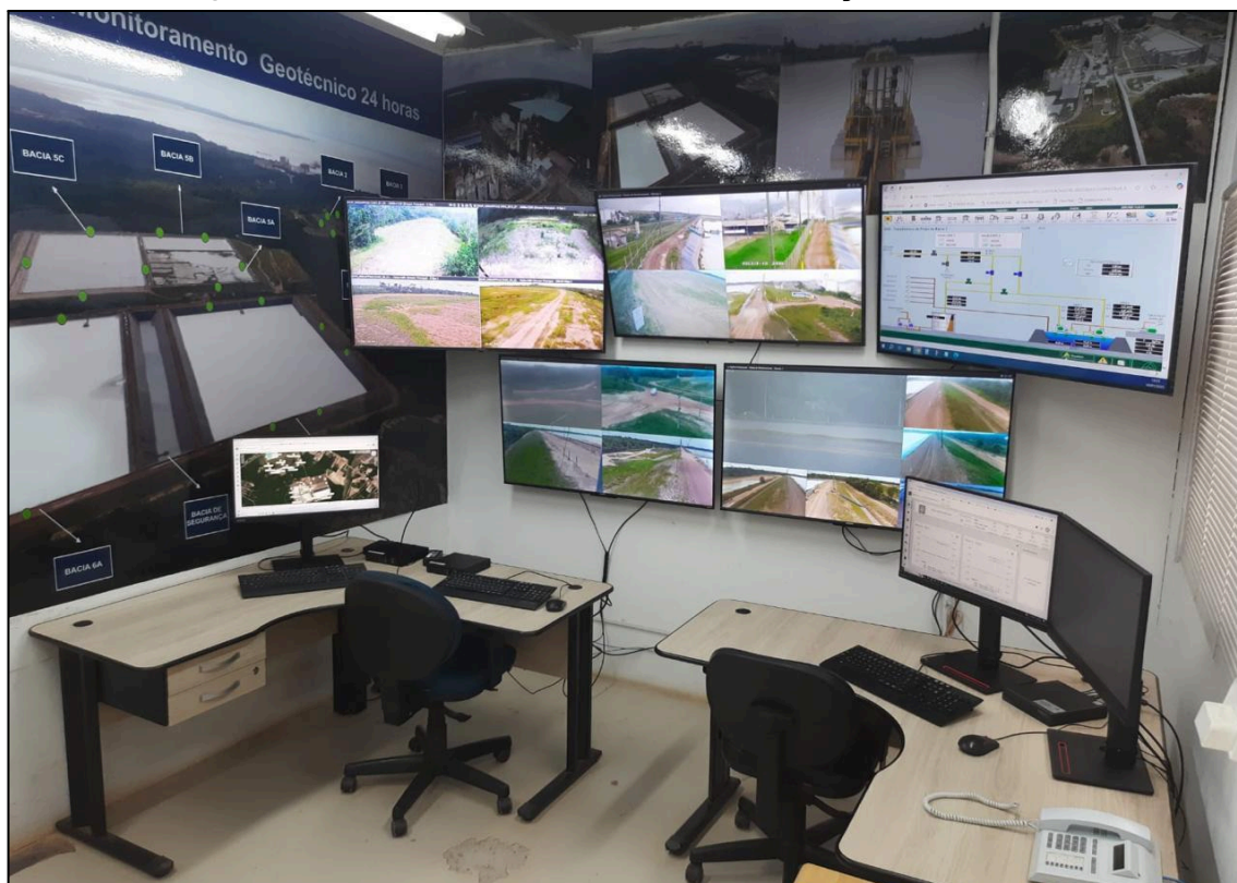
Figura 8-1 – Centro de Monitoramento e Inspeção da Artemyn.
