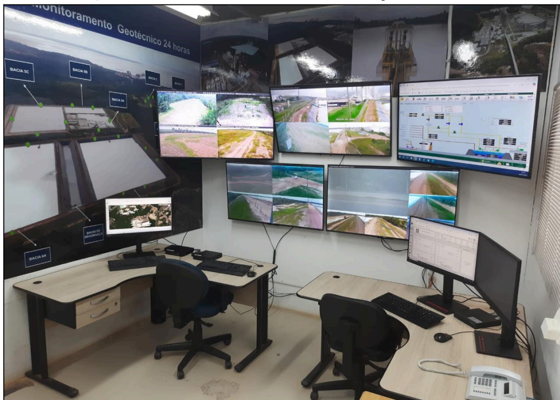
Figura 8-1 – Centro de Monitoramento e Inspeção da Artemyn.
