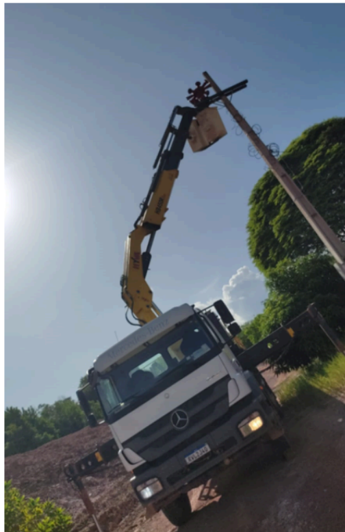
Figura 14-1 – Local de instalação da sirene
