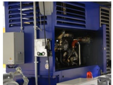
lärmgekapselter Motor
