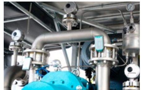
Überdruckschutz durch Bypass mit Berstscheiben
