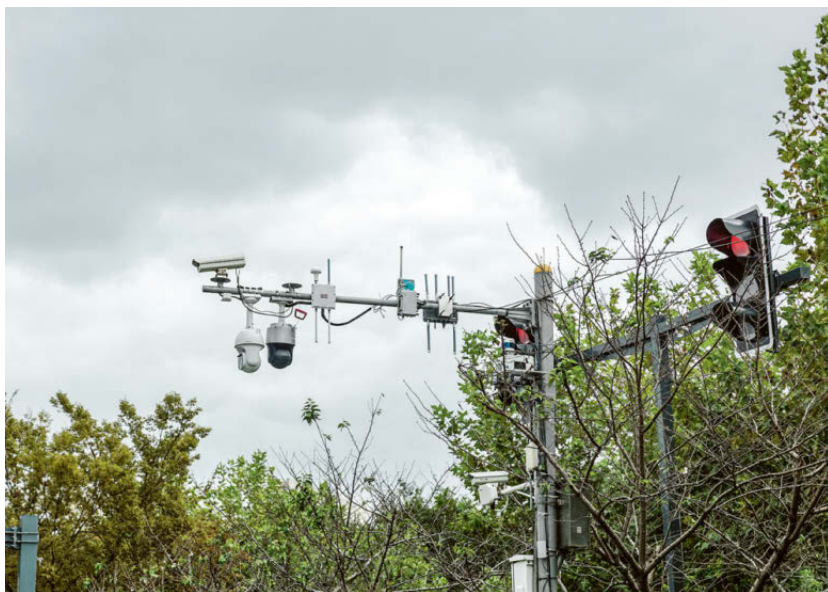
互联：无线通讯和激光雷达传感器在上海的智能网联汽车试验场被广泛使用。
