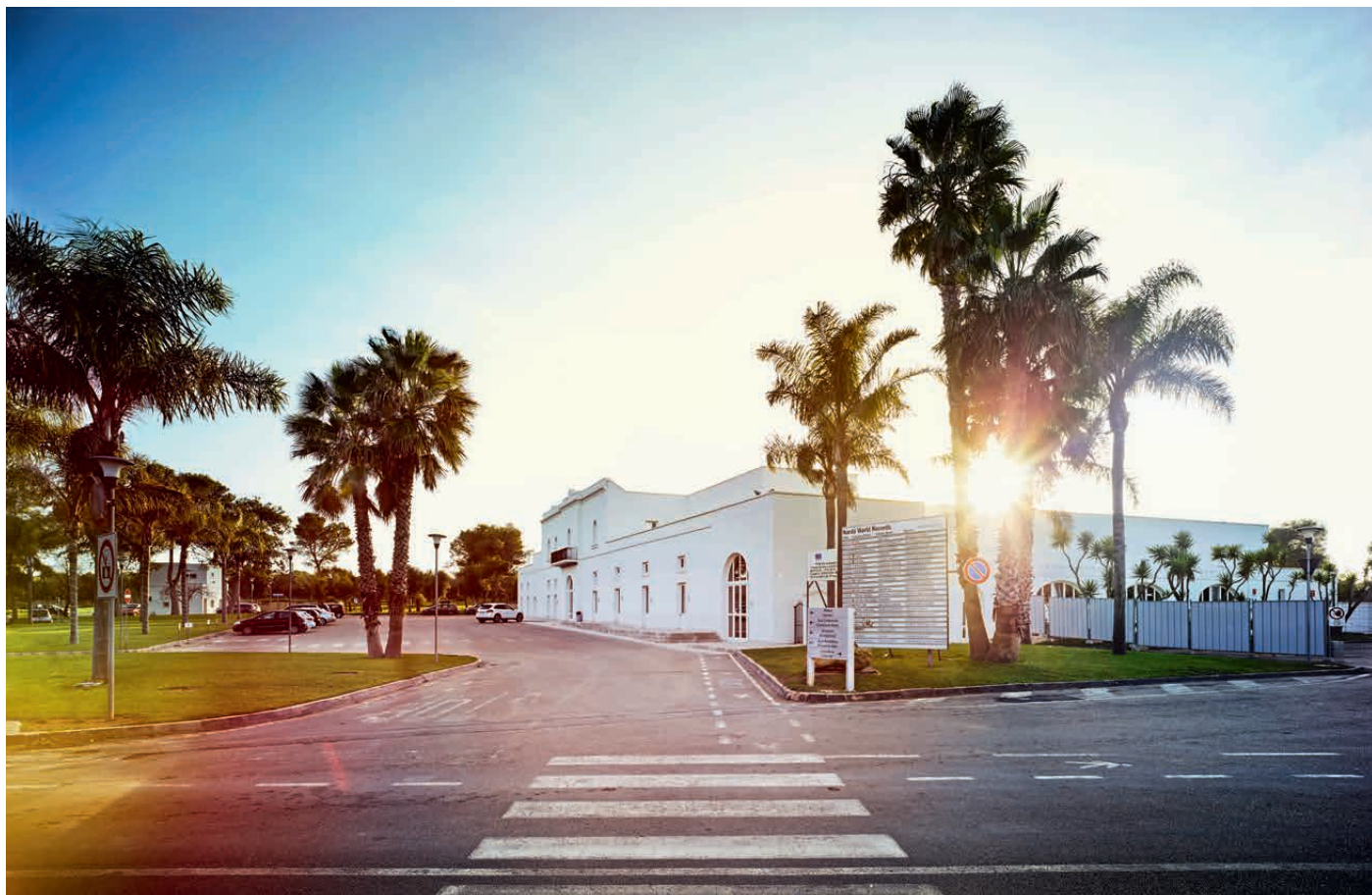
Historie bewahrt: Das Verwaltungsgebäude Masseria wurde komplett saniert. Dabei blieb der Charme des alten Gebäudes erhalten.
