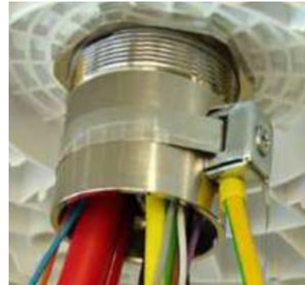
Abb. 115: Erdungsleitung Durchführung Dach
