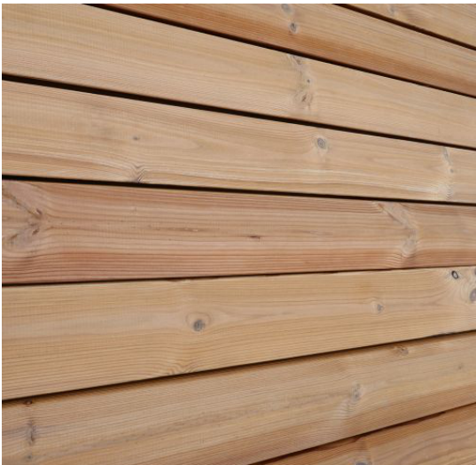
THERMOWOOD VÄRMEBEHANDLAD FURU (VID BALKONGER)
