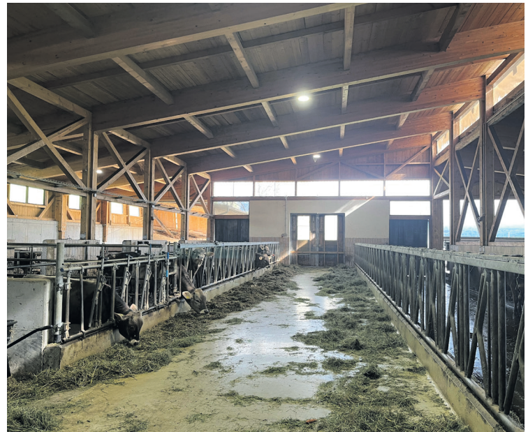
Im 2021 errichteten Laufstall wurden 300 Festmeter eigenes Holz verbaut.
