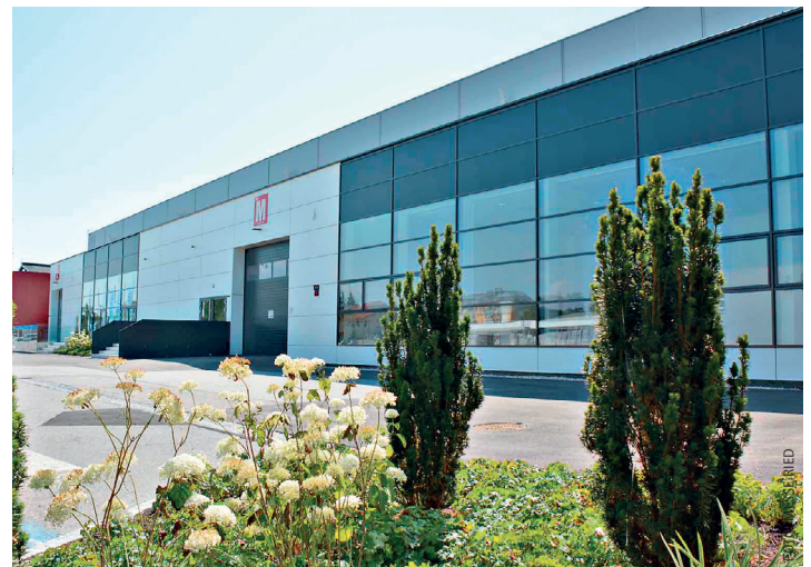
Ried/I.: Halle 19 bekommt ein Foyer und wird um 1.100 m 2 erweitert.
