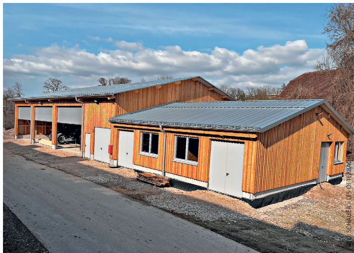
Die Halle bietet mit 465 Quadratmetern mehr Platz für den Unterricht.
