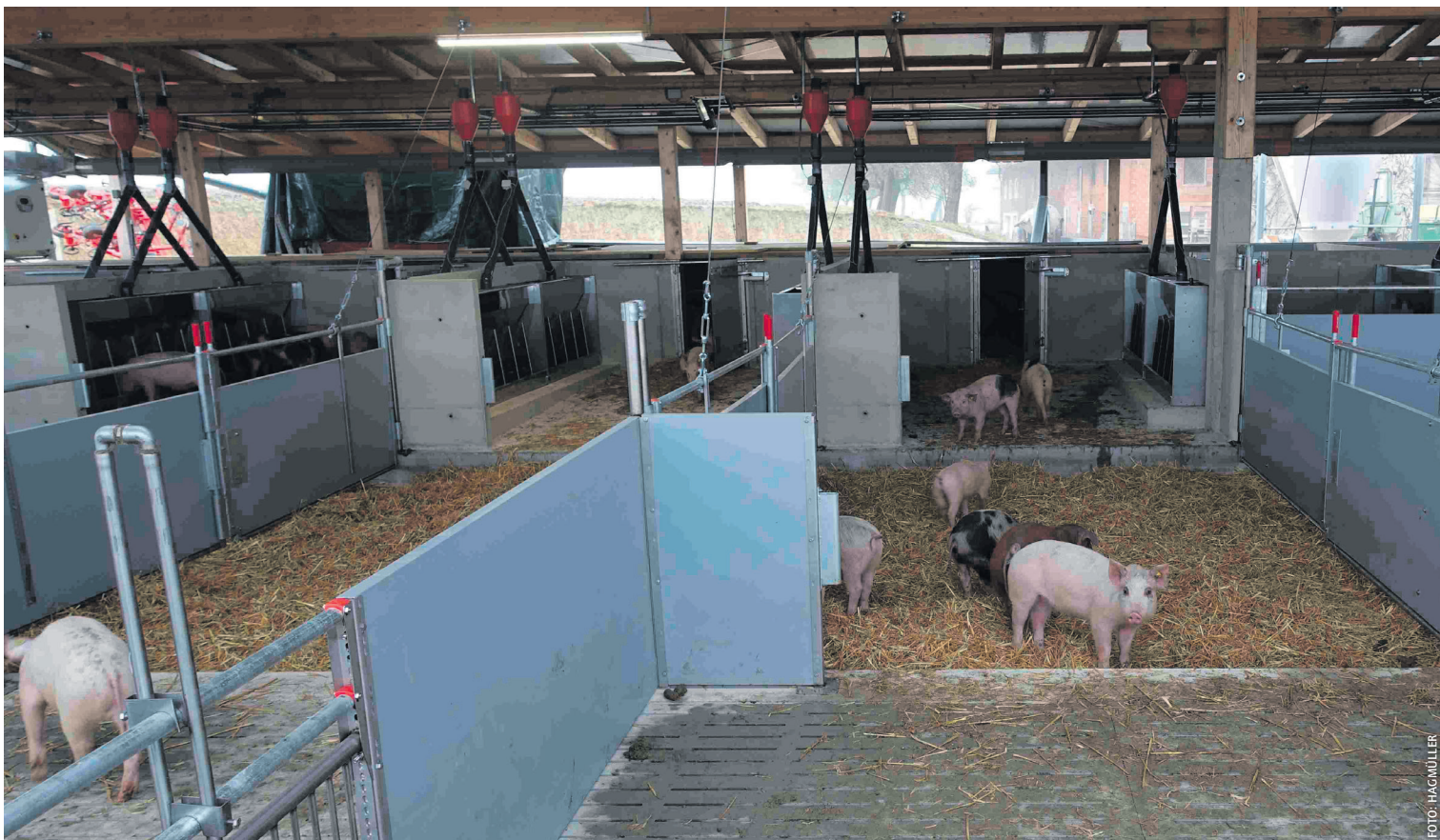
Spaltenelemente im nicht überdachten Ausscheidungsbereich und eingestreuter, geschlossener Aktivitätsbereich im überdachten Teil der Außenfläche
