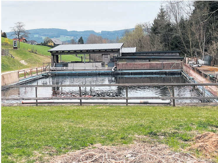
In Wenigzell erfolgt die Fischzucht in einem aufgelassenen Freibad.
