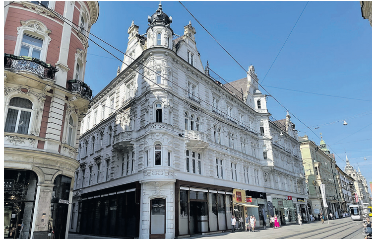
Die GRAWE erweitert ihr Liegenschaftsportfolio in der Grazer Innenstadt mit Häusern in der Herrengasse (Bild) sowie Am Eisernen Tor.
