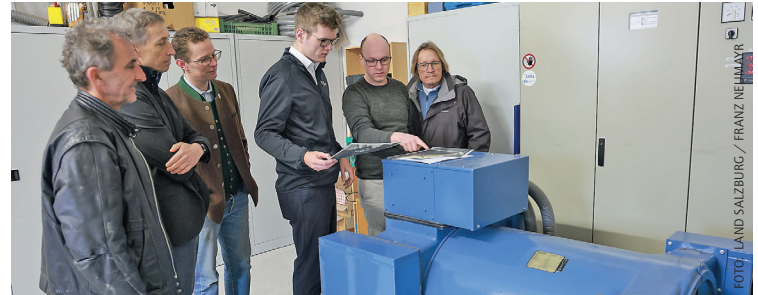
Landesrat Maximilian Aigner (3.v.r.) beim Kleinkraftwerk im Ebenauer Ortszentrum. Es liefert Strom für eine Energiegemeinschaft.
