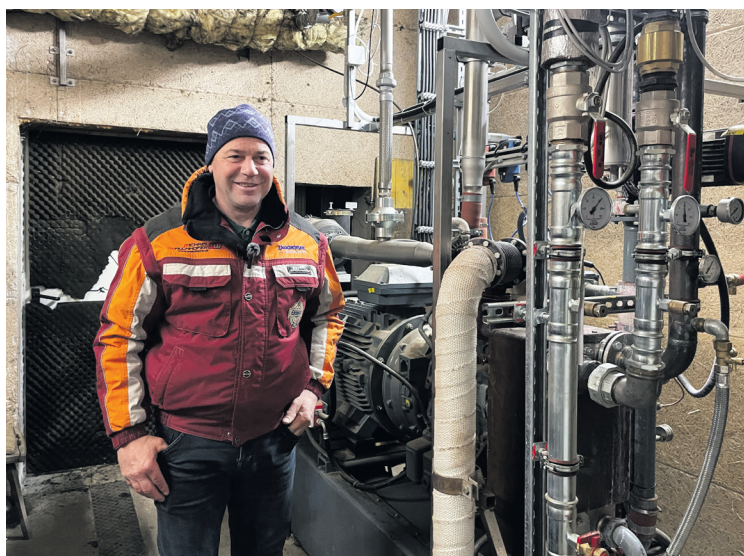
Ein Generator als Herzstück. Dieser wird mit dem hofeigenen Biogas betrieben und erzeugt rund um die Uhr Strom und Wärme für 180 Haushalte.
