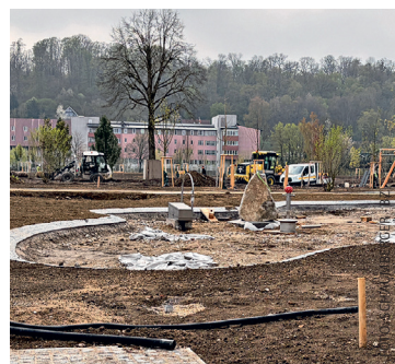
Im Bereich des Volksgartens werden bereits erste Arbeiten durchgeführt.
