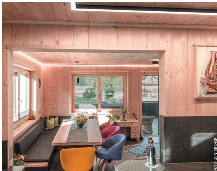
Alle Wohnräume inklusive Decken und Böden sind in Sichtholzqualität ausgeführt, für die Kopfwand des Schlafzimmers wurde Zirbenholz verwendet.
