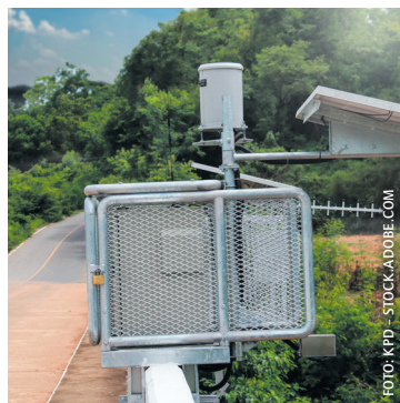
Errichtung von 13 neuen Stationen
