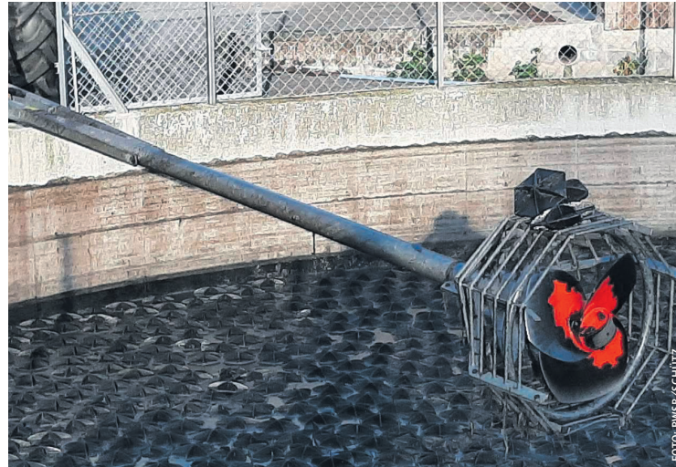
Bei Abdeckung mit Hexa-Cover muss der Mixer mit einem Korb versehen werden.
