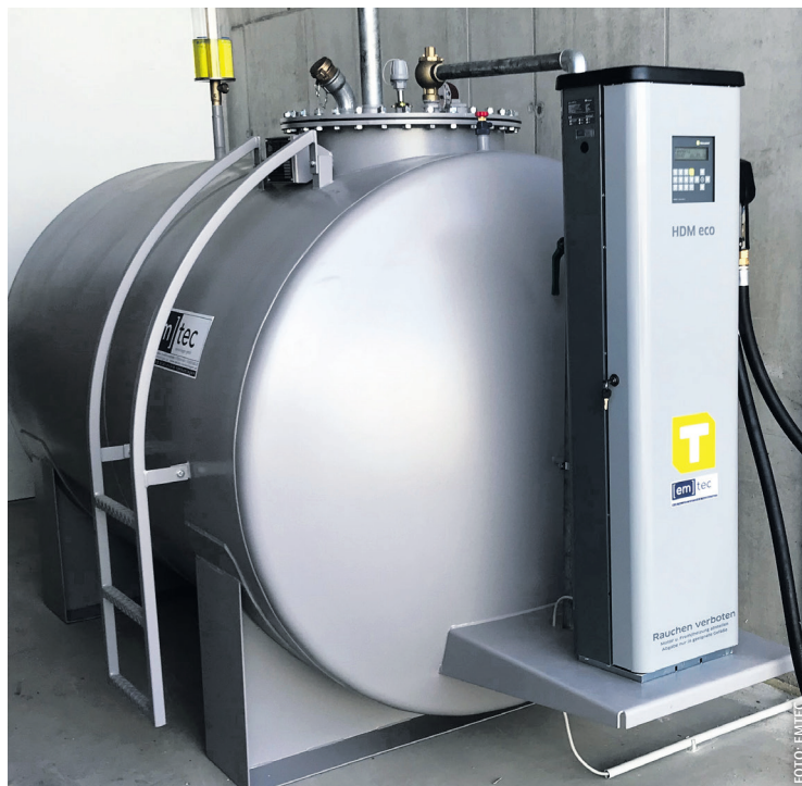
Ab 1.000 Liter Tankvolumen besteht Meldepflicht. Neue Dieseltanks müssen bei oberirdischer Verwendung die ÖNORM EN 12285-2 erfüllen.
