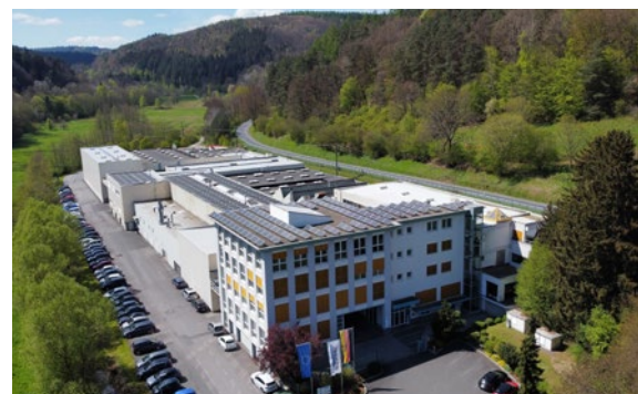
Wenzel fertigt technologische Spitzenleistung „made in Bavaria“.
