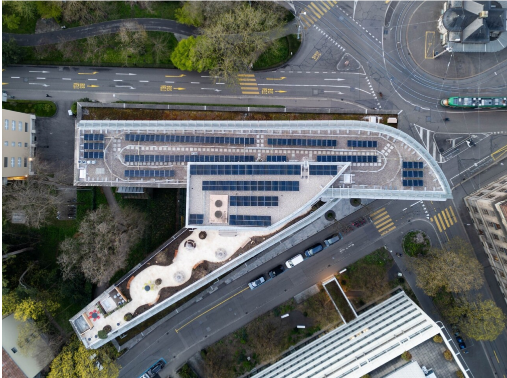
Installation photovoltaïque au siège principal de Pax à Bâle
