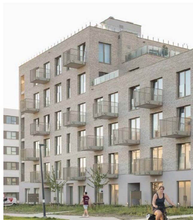
Appartementen gebouwen hebben een getrapte opbouw. Huurappart. 4 & 6 bouwlagen max. Koopappart. 4 & 5 bouwlagen max.
