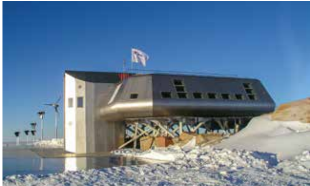
STATION PRINCESSE ELISABETH UTSTEINEN NUNATAK, ANTARCTIQUE Architecte Philippe Samyn & Partners Client International Polar Foundation Contrat Build (BESIX, Prefalux) Période 2007 - 2009
