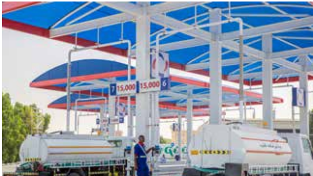
SAFI WATER REUSE STATION AJMAN, ÉMIRATS ARABES UNIS
