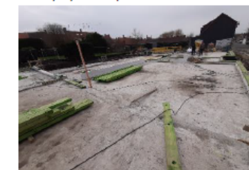
foto 09/02/23 vloerplaat en muurbasis
