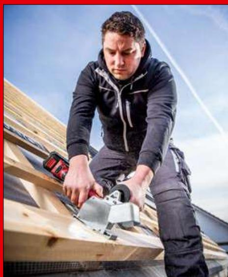
Avec une circonférence de préhension de seulement 147 mm, la poignée de la fraiseuse sur batterie pour poser les pattes de fixation des chéneaux tient bien en main.
