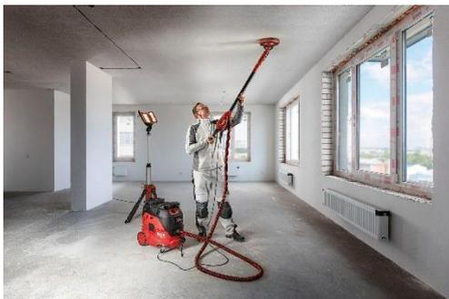
*La Giraffa più leggera di sempre: la maneggevole GE 6 R-EC opera con un peso inferiore del 50% e il 60% di potenza in più.*
