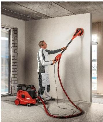
*La GE 6 R-EC dispone di un pratico segmento appiattito sulla testa di levigatura, quest'ultima in grado di ruotare di 160 gradi.*
