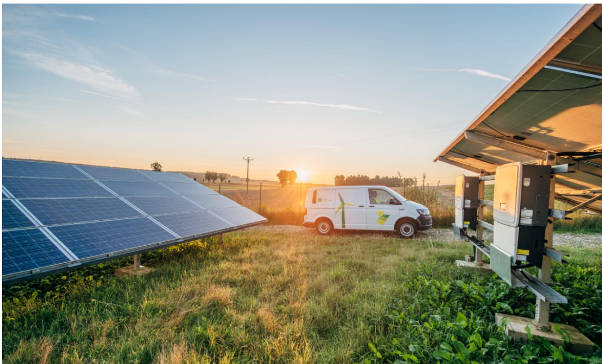
Foto: Underhåll av en befintlig BayWa solpark. Se växelriktarna på markställningarnas baksida.
