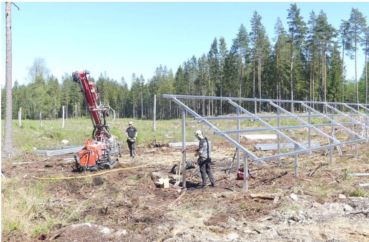
Foto: Pålningmaskin och byggnation av montagesystem för solpaneler i skogsmiljö.
