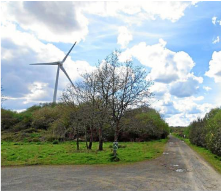
Sur le territoire, la société BayWa r.e. est également en charge de l’exploitation du parc éolien de Plésidy. Société BayWa r.e.
