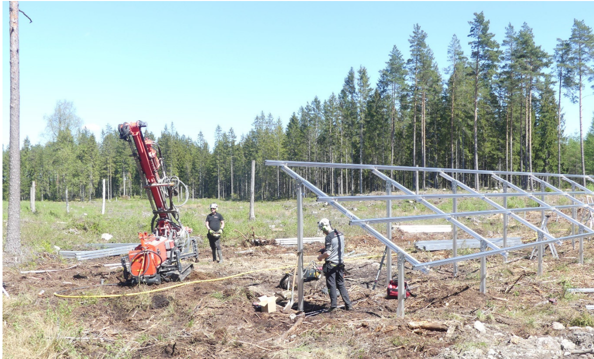
Bild på pålningsmaskin och byggnation av montagesystem för solpaneler i skogsmiljö.
