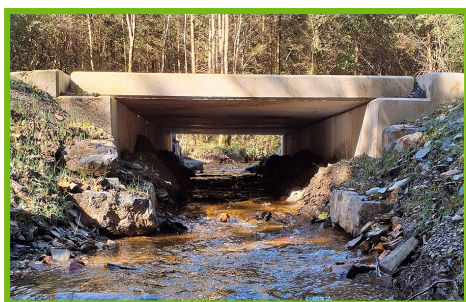
Ponceau pour franchir le cours d'eau
