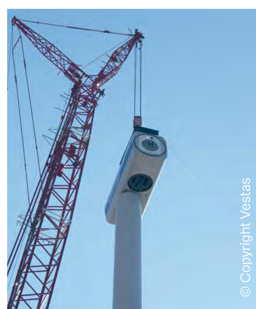
Montage der Gondel auf dem Turm
