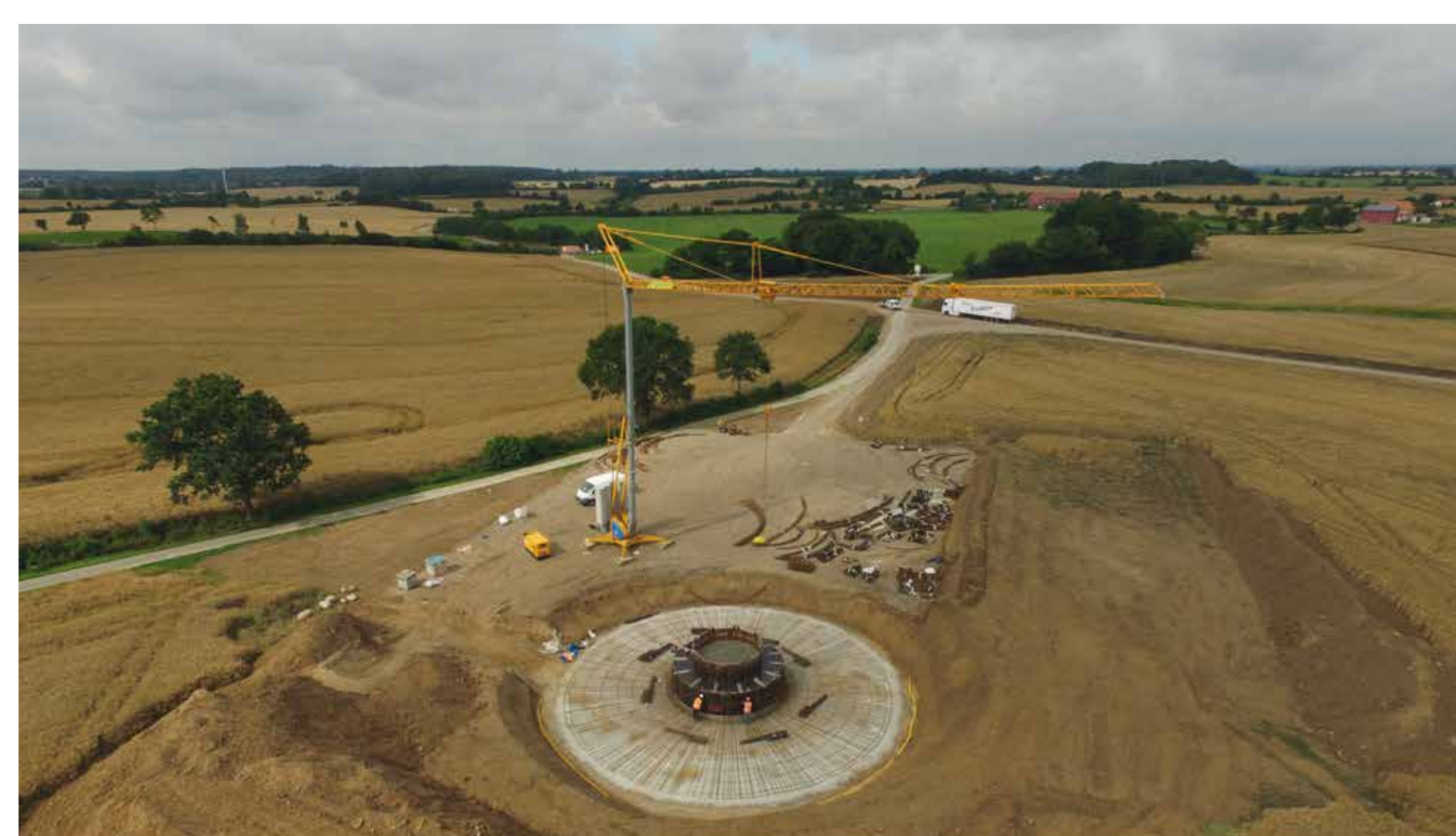
Fundament aus Stahlbeton
