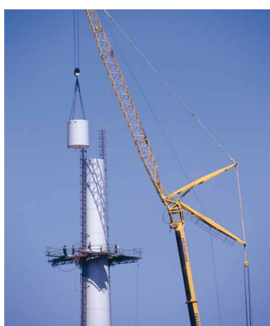
Aufbau eines Turmes aus Stahlrohr
