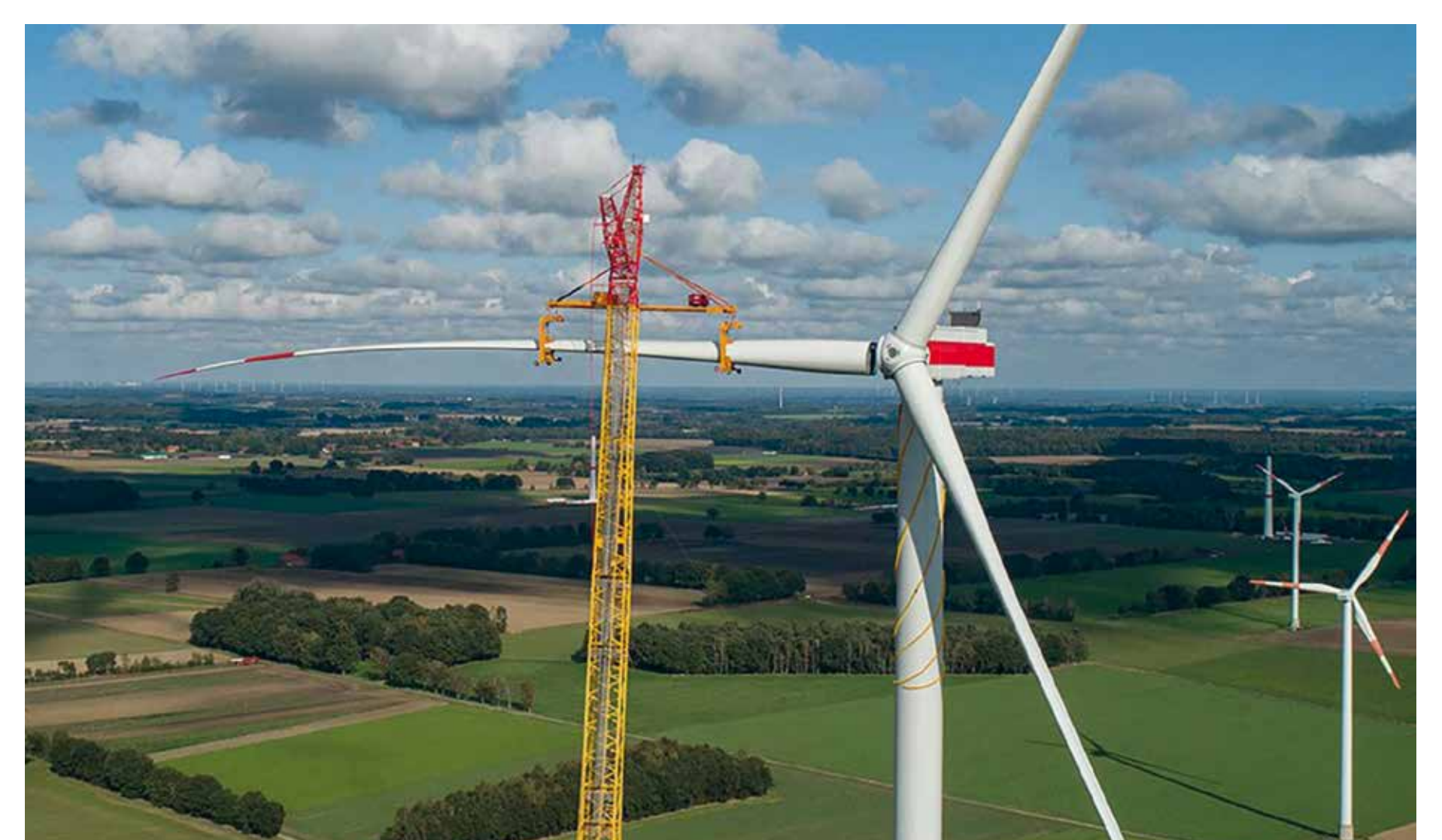
Montage eines Rotorblattes
