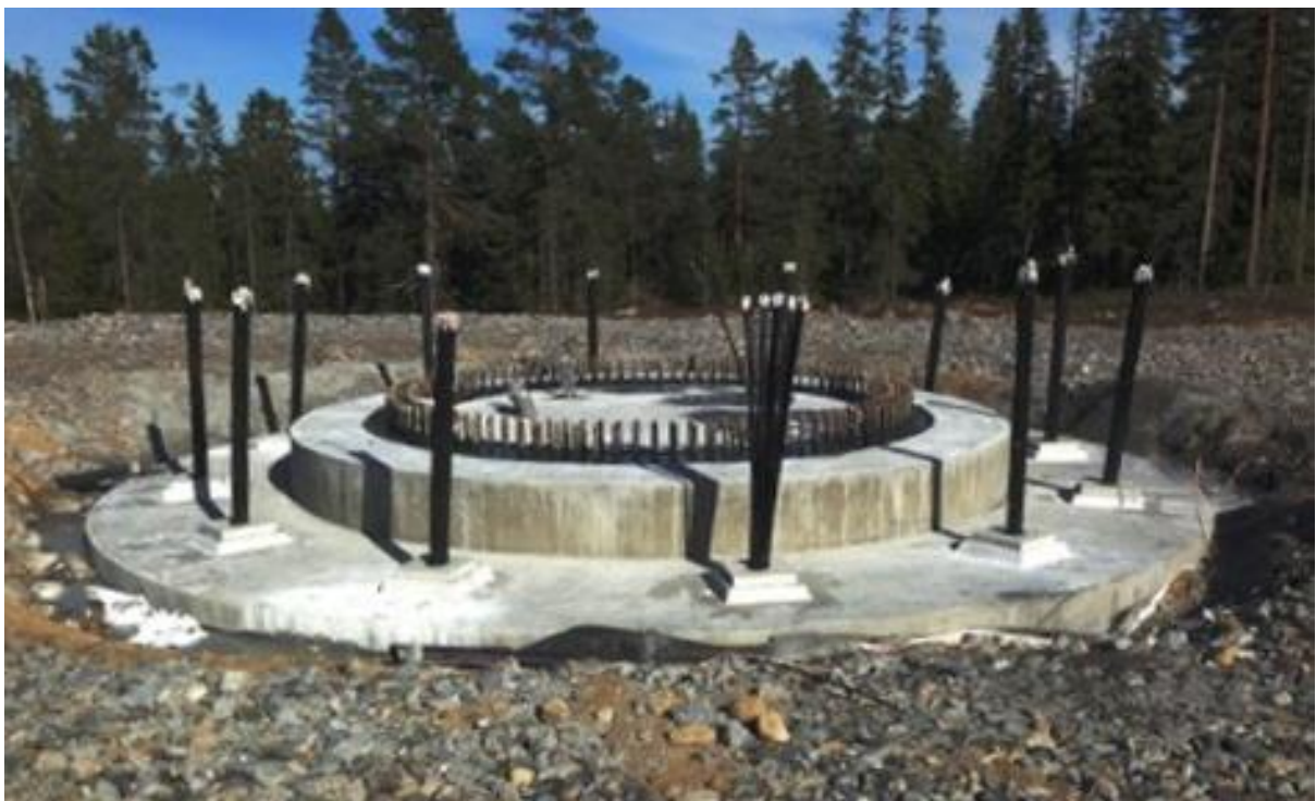
Figur 19. Bergsfundament.
